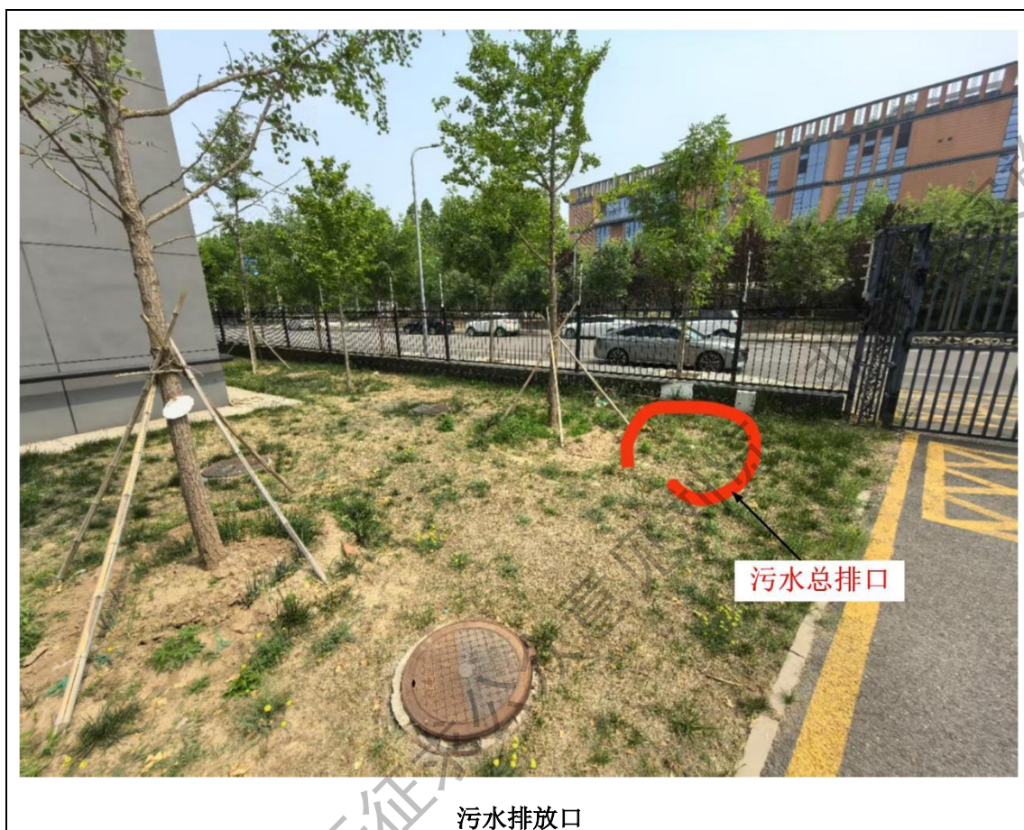
图 3-2 本项目污水总排口
