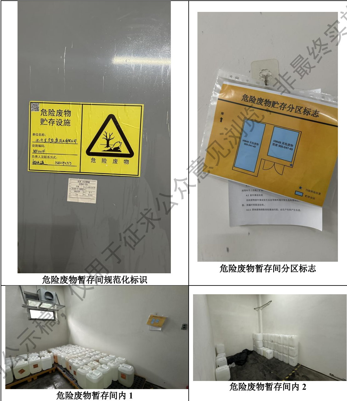
图 3-3 本项目危废间现场情况
